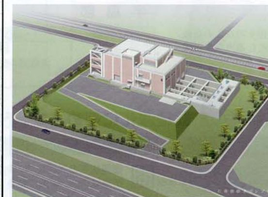
S.石巻中央排水ポンプ場 概要
